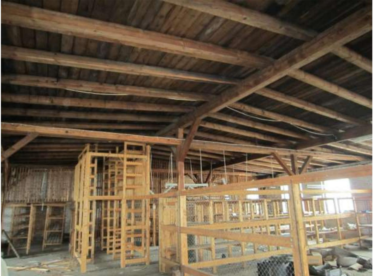
Abbildung 4: Obergeschoss des Fabrikgebäudes mit freier Sicht auf das von unten mit Brettern verkleidete Dach.
