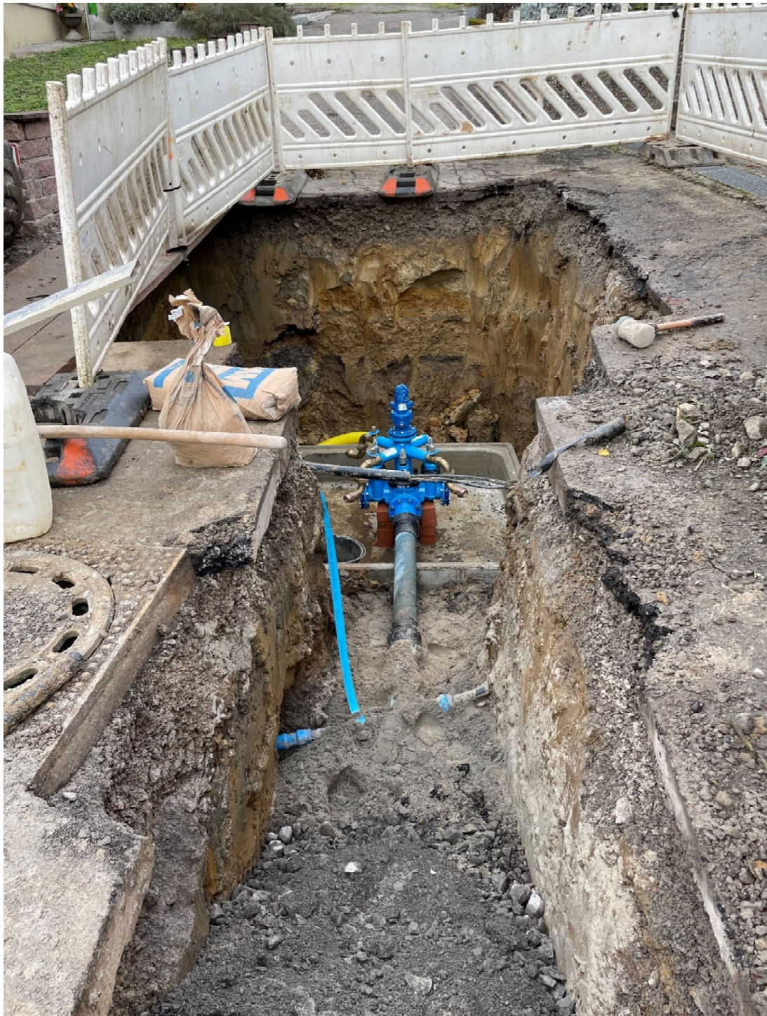
Erneuerung Wasserleitung Furtstraße in Bachenau
